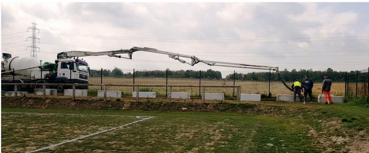
*Remplissage de la fondation avec du béton armé*
