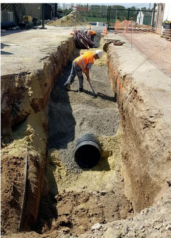
Après une étude d'inspection télévisée de la canalisation, le rapport confirme ce que l'on craignait, celle-ci est effondrée par endroit et passe sous une habitation et des bâtiments privés. Nous avons lancé une étude de faisabilité pour construire une canalisation dimensionnée et normalisée à la réglementation de la loi sur l'Eau.
