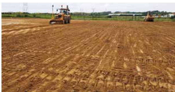
*Niveleuse équipée d'un guidage laser*
