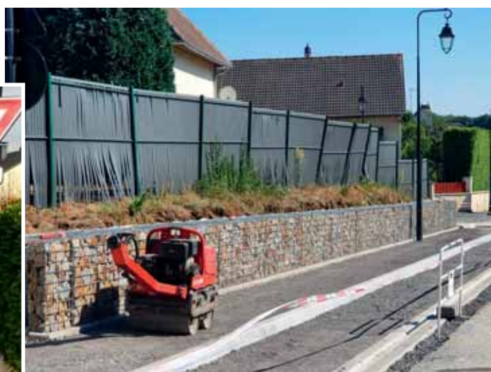
L'aménagement d'un mur de soutènement en Gabion a permis la création de 8 places de parking.
