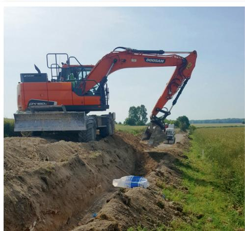
La commune d'Arsy a créé une canalisation d'eau potable depuis la station de forage de Gansoive jusqu'à la station d'Arsy, soit 1850 mètres de canalisation à travers le territoire de Canly. La municipalité a profité du passage de l'eau potable pour alimenter la cuve de 120 m<sup>3</sup> de la défense incendie de la ferme de Villerseau.
