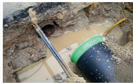
*La nouvelle canalisation en fonte vient prendre la place de l'ancienne en béton tout en respectant les autres réseaux. Ici sur la photo le gaz et la fibre*
