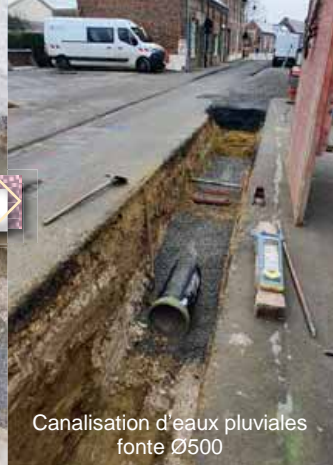
Modification de raccordement des eaux usées
