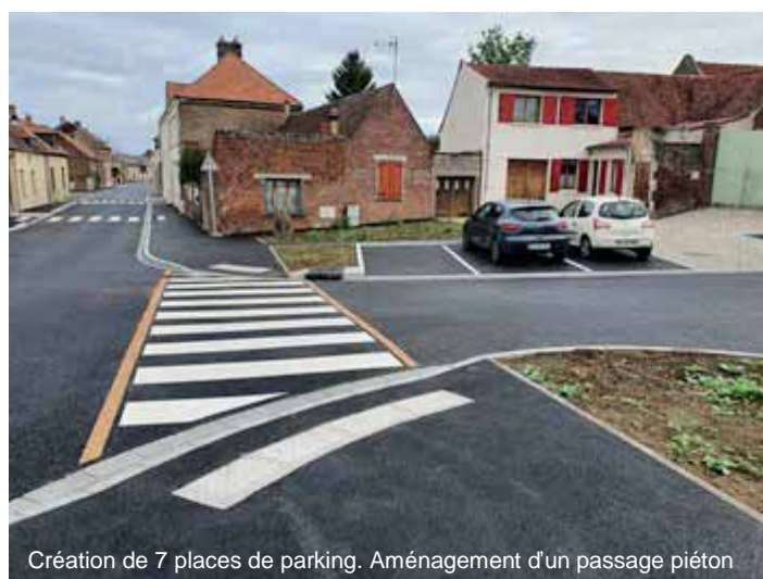
Aménagement de 7 places de parking
