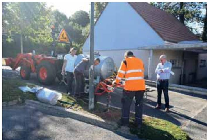
Pose des bornes à l'aide d'une tarière thermique
